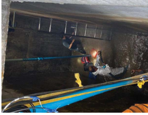
หัวข้อ 3.3.1 การล้างทำความสะอาดถังสำรองน้ำใช้
